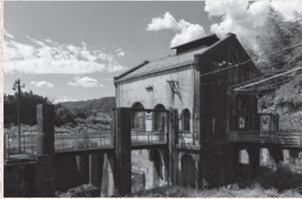
電力需要が増した1917(大正6)年に、本館の隣につくられた「放水口発電所」。本館発電所の放水口から出る落差7mの水を再利用して発電。(現在、内部の常時公開はされていません)
