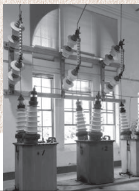
1階送電棟にある母線室。高電圧に耐えられるよう、天井(2階床)は耐火構造になっている。
