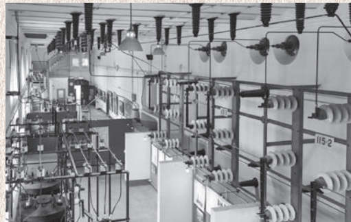
1階送電棟にある母線室。高電圧に耐えられるよう、天井(2階床)は耐火構造になっている。
